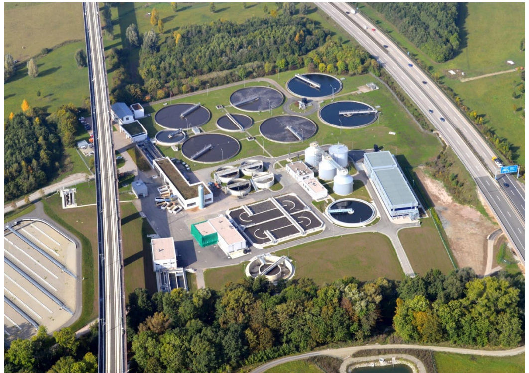
Verbandskläranlage Arnstadt in Ichttershausen - Inbetriebnahme 1995; 1. Erweiterung 2007 und 2. Erweiterung 2015/2016 für das Industriegebiet Erfurter Kreuz
