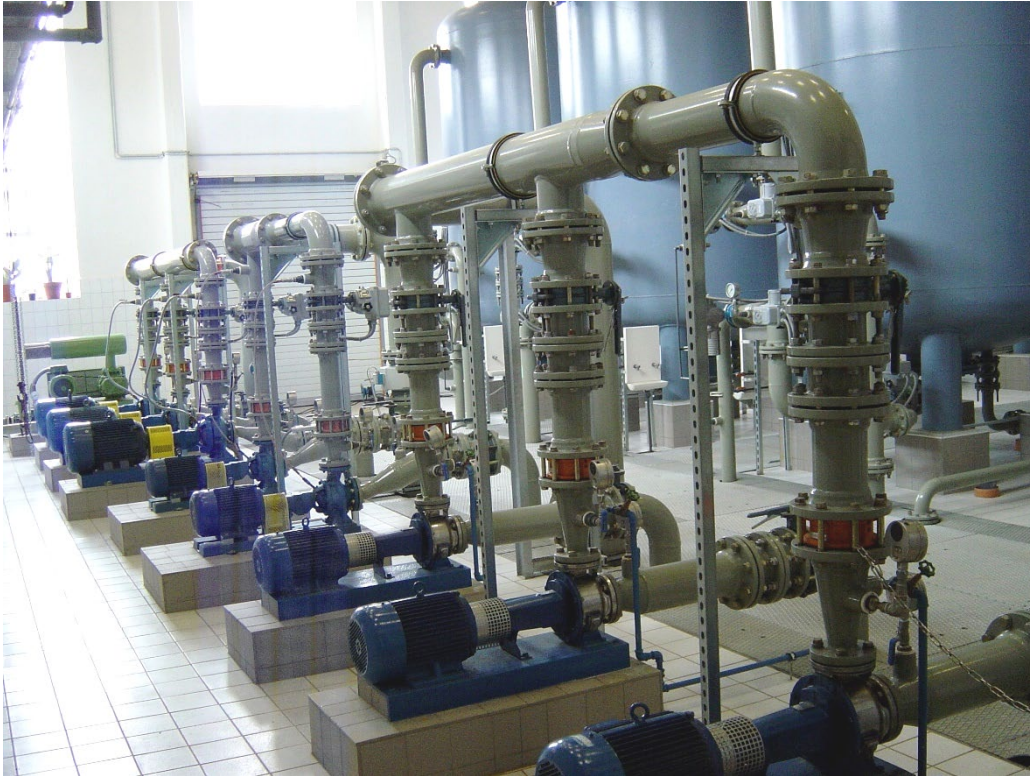
Wasserwerk Dörfeld – modernisiert und erweitert 1995
